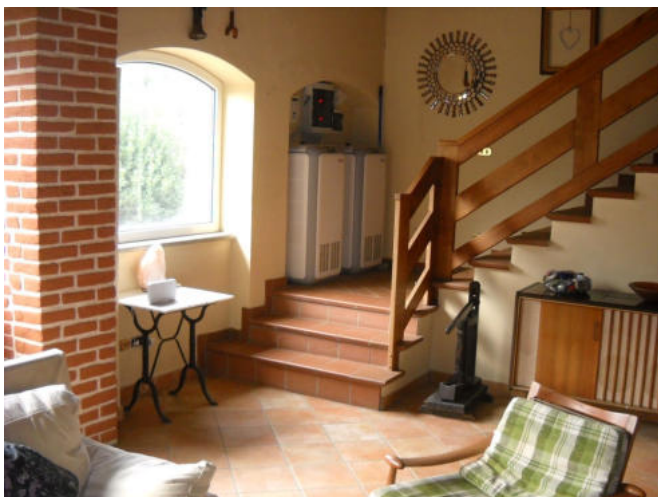
Scala di collegamento piano primo con mansarda mappale 488 sub.2
