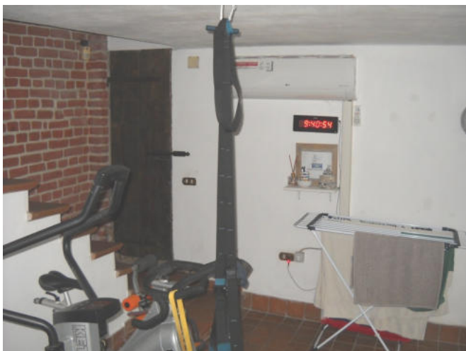
Impianto fotovoltaico mappale 488 sub.1 piano terreno
