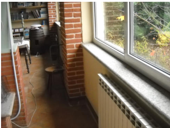
Dettaglio serramenti e radiatori mappale 488 sub.2 piano primo
